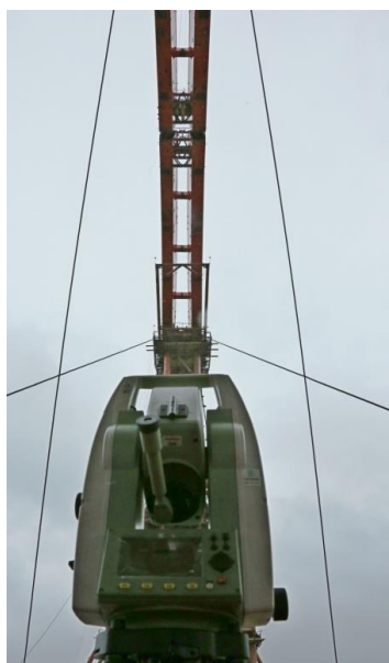
Рис. 4. Контроль перемещения пролётного строения с использованием электронного тахеометра LeicaTS 06
