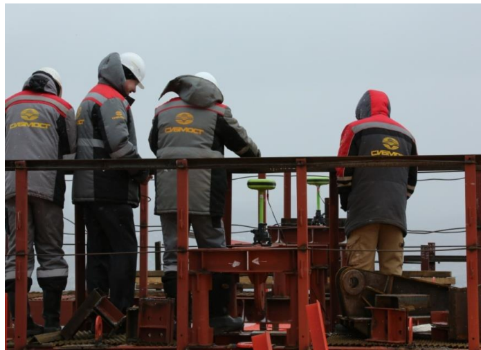
Рис. 2. Установка приёмников ГНСС на двух полусводах арки
