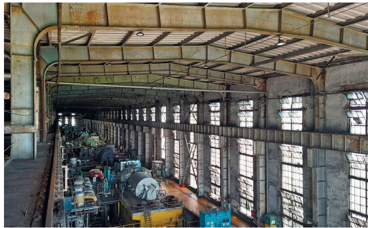
Рис. 1. Общий вид надземного кранового пути
